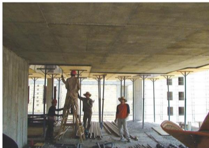
شکل ۱۱: باز کردن قالب
