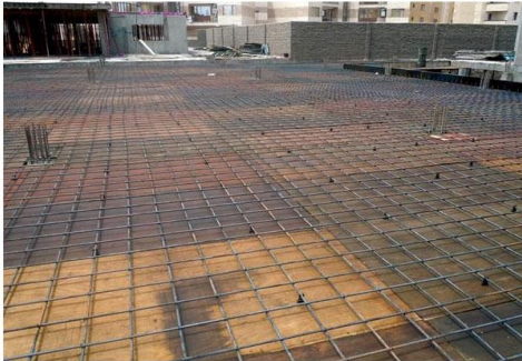
شکل ۷: اجرای شبکه آرماتور پایینی
