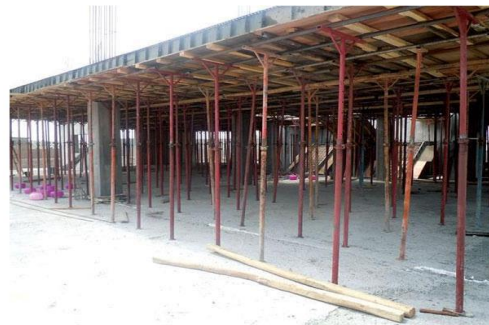
شکل ۶: قالب بندی سقف
