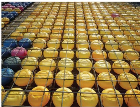
شکل ۹: اجرای شبکه آرماتور بالایی
