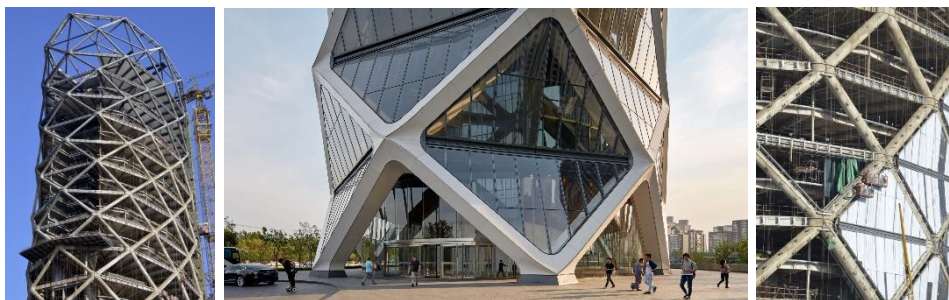
شکل شماره ۱۴: نمونه ای از سازه های دایاگرید با مصالح کامپوزیت. برج بین المللی پلی، دوانگجینگ، چین
