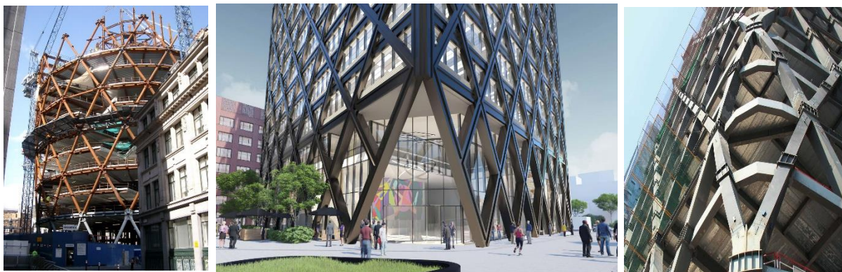
شکل شماره ۱۲: نمونه ای از سازه های دایاگرید با مصالح فولادی
