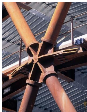
شکل شماره ۳: گرهها عامل اتصال اعضای مورب قطری و افقی به یکدیگر می باشند.
