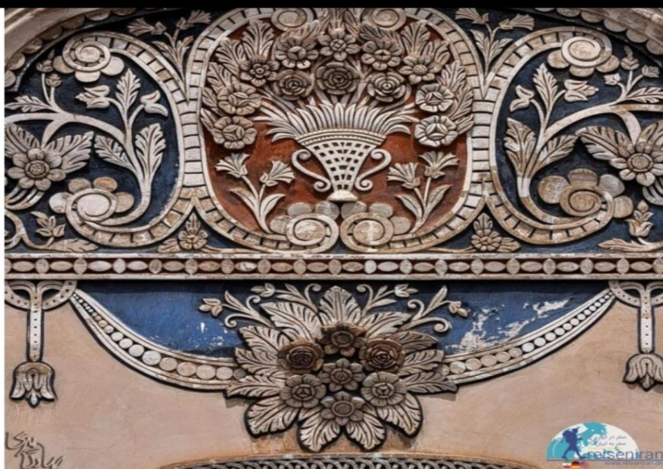
گچکاری های بیرونی خانه
